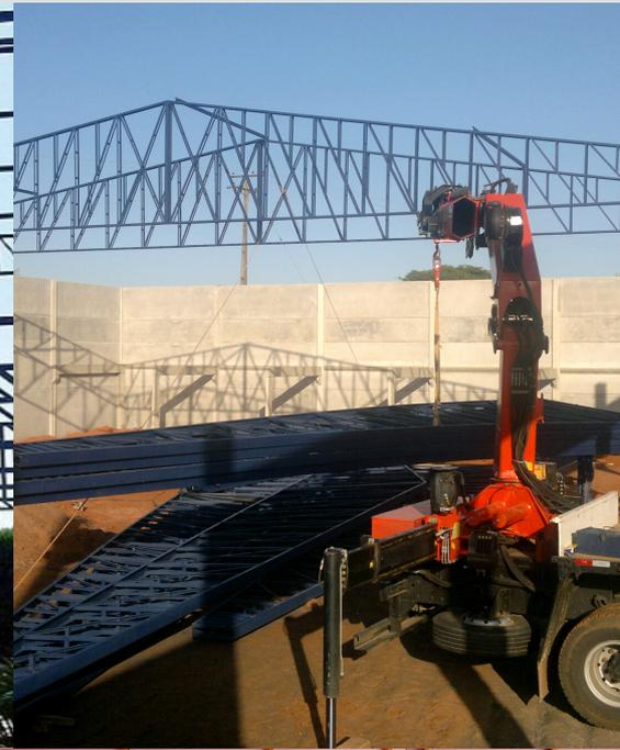
As estruturas metálicas suprem grandes vãos e cargas com perfis leves, que são produzidos em ambientes adequados, minimizando perdas e poluição e, tudo isso, com valores reduzidos perante outros métodos construtivos.
